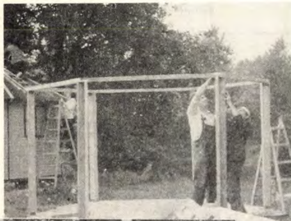
A – Az alapkereten, illetve a padozaton felállított, szerelés alatt álló vázszerkezet.
