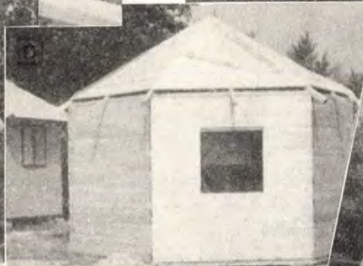
D – Már csak a párkánydeszkák hiányoznak, azután megkezdődhet a tetőfedés.
